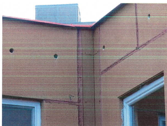
č. 20 – 21 Detaily dilatačních spár, jihovýchodní a severozápadní průčelí
