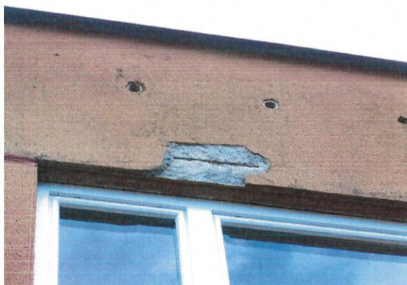
č. 22 – 23 Detaily poškození obvodového pláště, severozápadní průčelí
